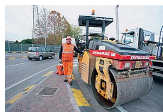
Cantiere I mezzi al lavoro.
